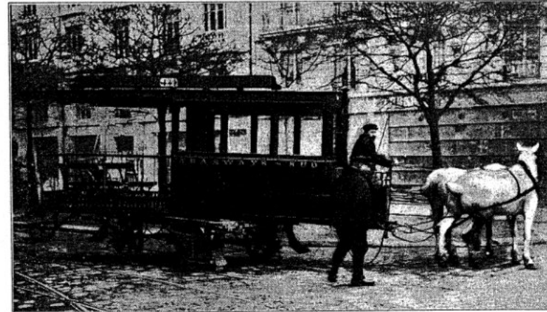
Bild 2.3/8: Drehung eines Wagenkastens auf dem Untergestell bei einer Pferdeeisenbahn.
