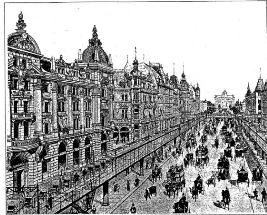
Bild 2.4.1/1: Idee einer „Straßenbahn“ als Stufenbahn (um 1890) Vorgesehen als Hochbahn mit drei „Förderbahnen“ (links und rechts vor den Gebäuden laufend) zur Personenbeförderung in großen Städten.
